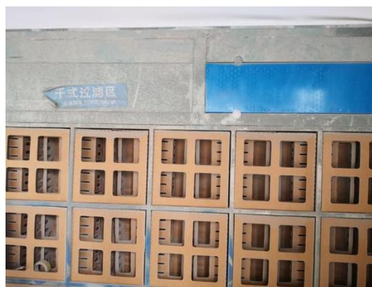
干式过滤箱（喷漆废气）
