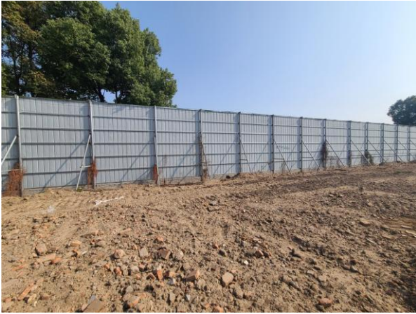
项目东侧现状（阻挡外雷州大道）
