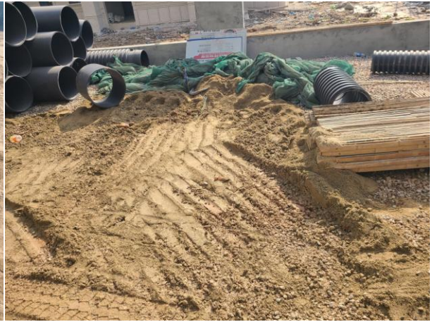
待补充土保持措施（苫盖）
