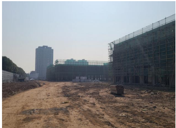
项目建设情况（在建一条内部道路）
