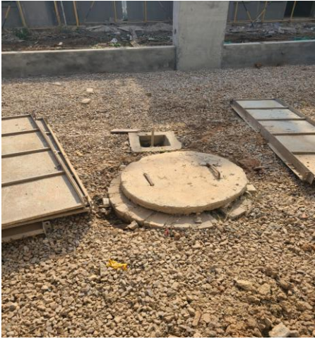
项目建设现状（在建沉沙池）
